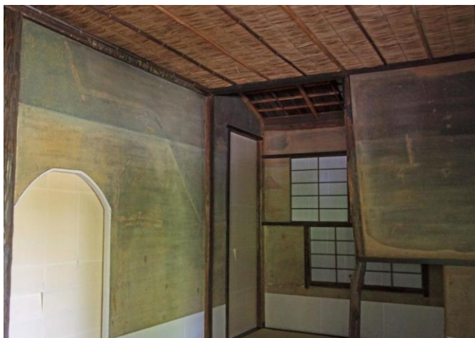
松琴亭茶室の菰天井
